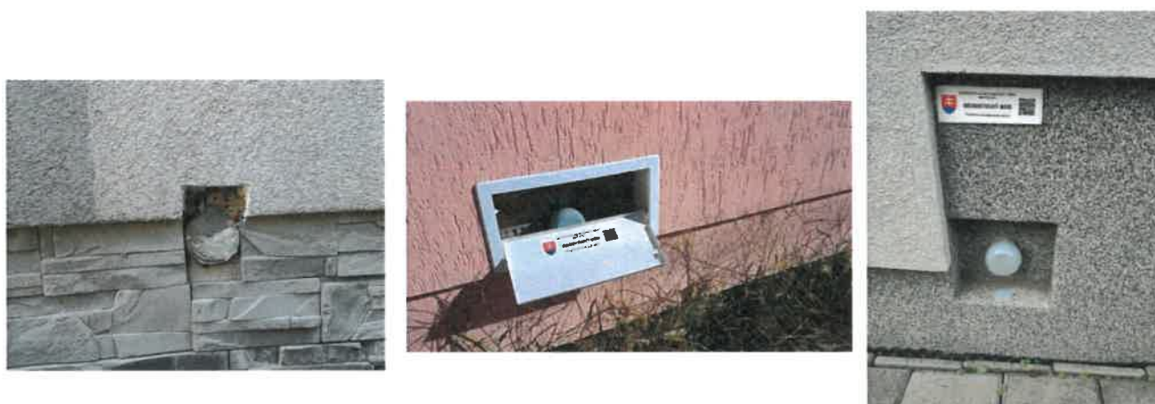
Obr. 3 Príklady vynechania výrezu: Geodetický bod môže ostať na fasáde priznaný alebo zakrytý plastovou chráničkou, prípadne kovovou mriežkou
